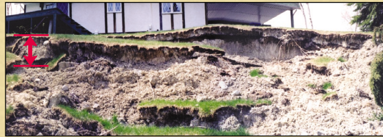
Remblai de terre au sommet d'un talus
